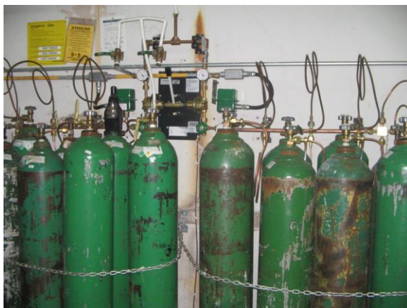
Figura 1 – Suprimento reserva de cilindros de oxigênio. Fonte: Marisol Pais Lopez.
