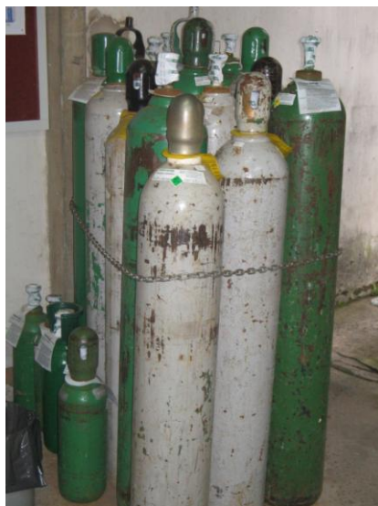
Figura 6 – Armazenamento de cilindros de variados tamanhos e tipos gases.
