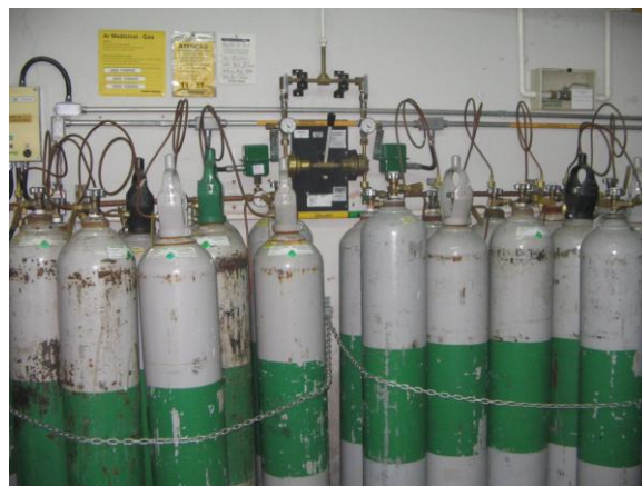
Figura 2 – Suprimento reserva de cilindros de ar medicinal. Fonte: Marisol Pais Lopez.
